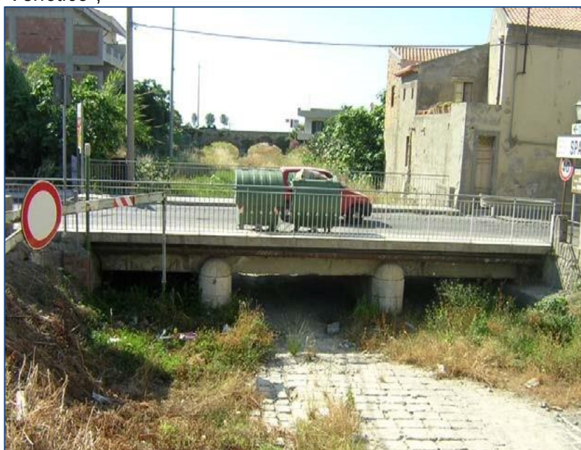
Foto 1: Rio Cocuzzaro: ponte della strada comunale.
